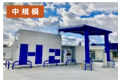
エア・リキード神戸空港前 水素ステーション(R5.5開所)
