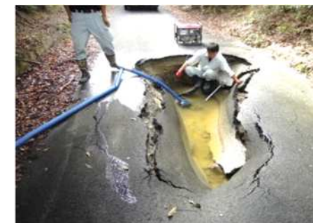
パイプライン破損による道路陥没 (断水・通行に支障)
