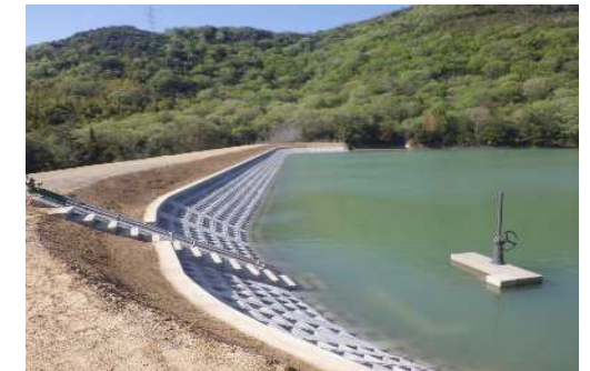
地震対策工事が完了したため池 (姫路市 大谷池)
