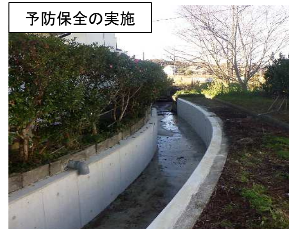
コンクリート増厚による水路補修
