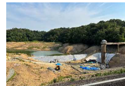
改修工事中の船木(ふなき)池 (小野市)
