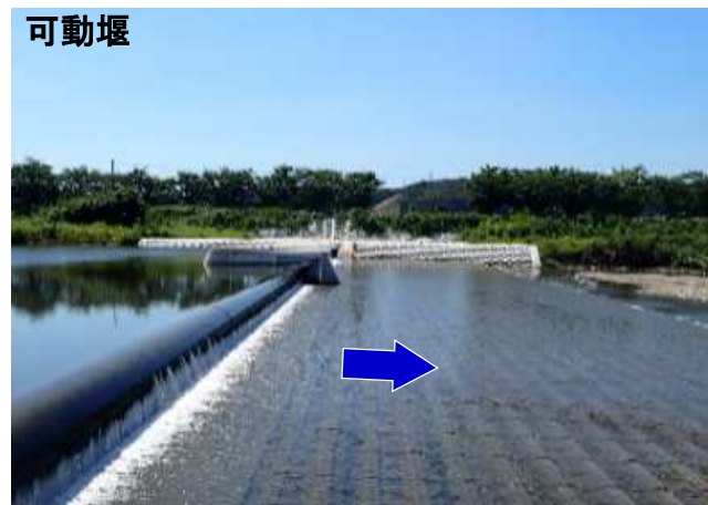
洪水を安全に流下させる可動堰へ改修（三木市和田（わだ）井堰）
