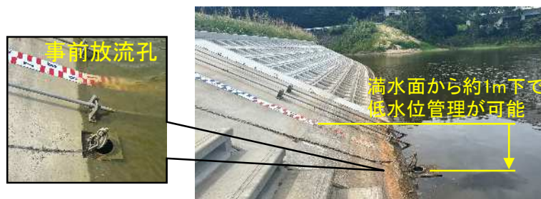
工事で整備した事前放流施設（洲本市）
