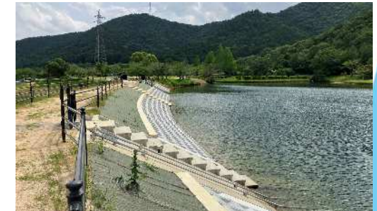
侵入防止柵と這い上がりに配慮した護岸
