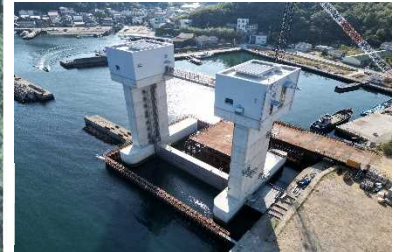
本港地区港口水門 施工状況
