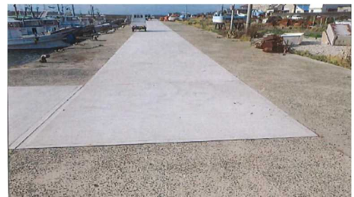
仮屋漁港物揚場 整備後
