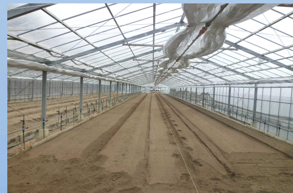
内張カーテンを増設して二重カーテンにしたハウス（神戸市）
