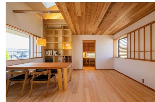
CLTを活用し、柱のない空間が特徴のモデルルーム (加古川市)
