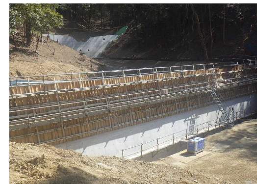
県産木材型枠を利用した治山工事 (川西市)
