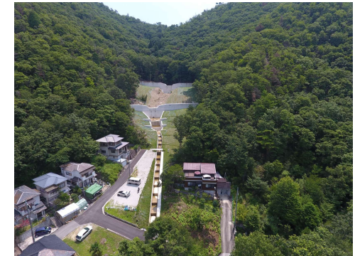
集落を保全する治山ダム (三田市)
