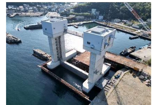
沼島港口水門の施工状況 (南あわじ市)
