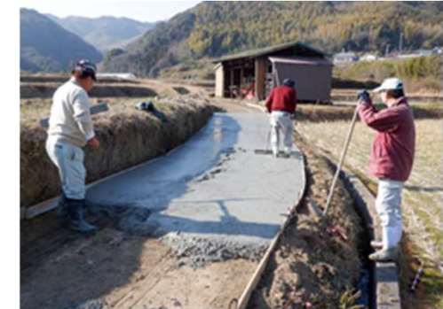
直営施工による農道の舗装 (洲本市)
