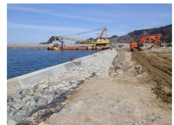
香住漁港 岸壁耐震化施工状況
