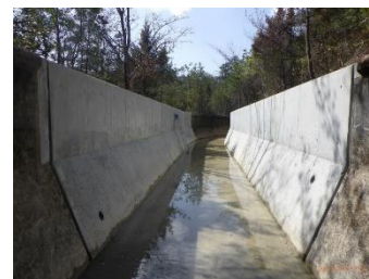
老朽化した用水路の長寿命化対策 （加東市鴨川導水路・国営東条側 2期地区）
