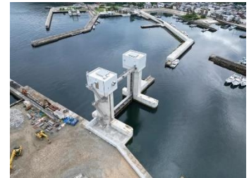
沼島漁港 本港地区港口水門 施工状況
