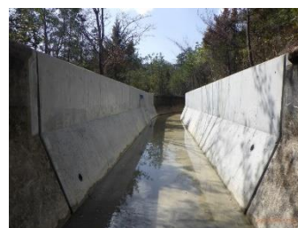
老朽化した用水路の長寿命化対策 (加東市鴨川導水路・国営東条側2期地区)
