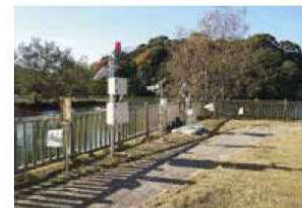
ICT の活用によるため池遠隔監視 (淡路市)
