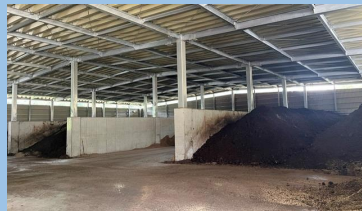
ブローア付き堆肥調整保管施設
