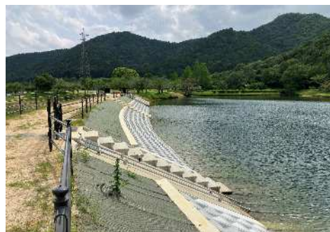
耐震補強工事が完了したため池（西脇市）
