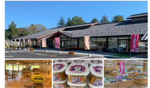
改修された「味わいの里三日月」
