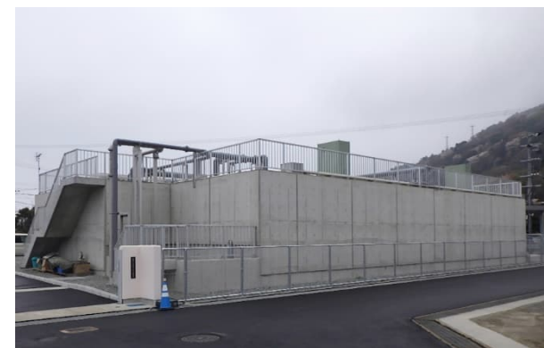
改築された排水処理施設（香美町）
