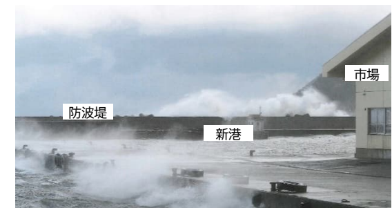
越波が発生し、港内が荒れている様子
