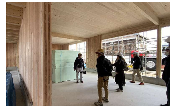
CLTを活用した社屋ビルの建設 (姫路市)
