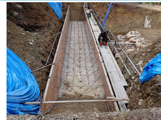
県産木材型枠を利用した治山工事 (多可町)
