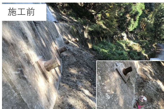
アンカー工頭部キャップの劣化
