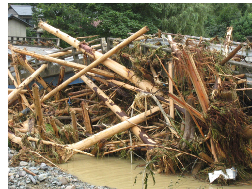
流木による橋梁部の閉塞
