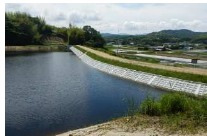
ため池改修完了（洲本市 長津路池）
