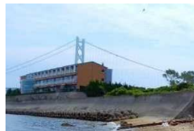
松帆崎海岸 防潮堤（淡路市）
