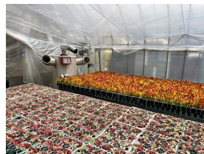
温風暖房機を導入したハウス(養父市)
