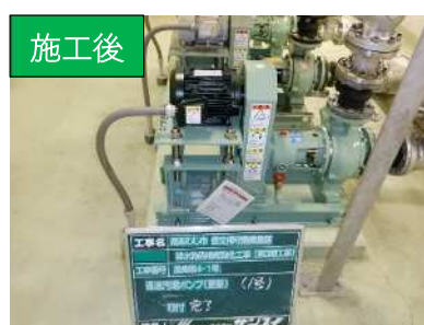
汚泥ポンプ交換により機器機能を回復
