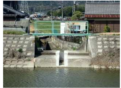
洪水吐切り欠きを活用した事前放流（高砂市三日月池）
