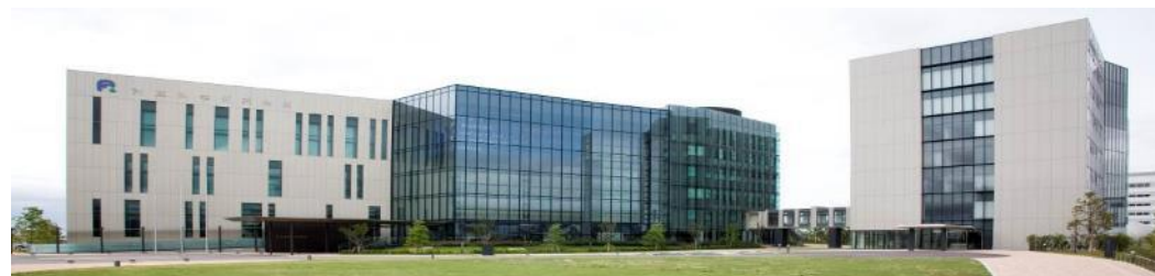
スーパーコンピュータ「富岳」施設
