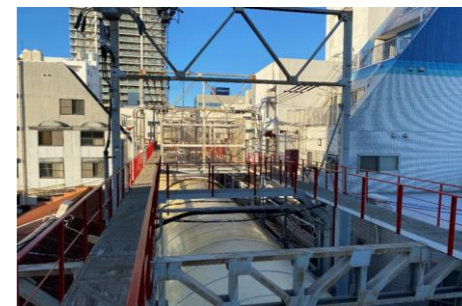
アーケード改修 (屋上歩廊修繕)
