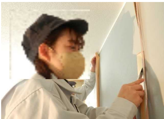
内装施工実習 (神戸高等技術専門学院：インテリアリフォームコース)
