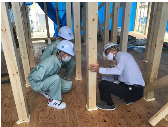
木造建築現場実習 (但馬技術大学校：建築工学科)
