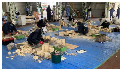
技能検定実技試験（築炉）
