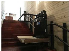
写真22 車いす用階段昇降機の設置
