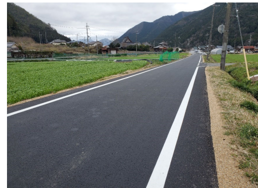
町道上岩宮野線の舗装修繕(神河町)
