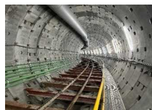
地下貯留管整備 津門川(西宮市)
