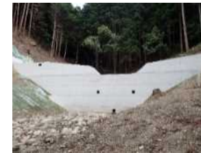
治山ダムの整備
