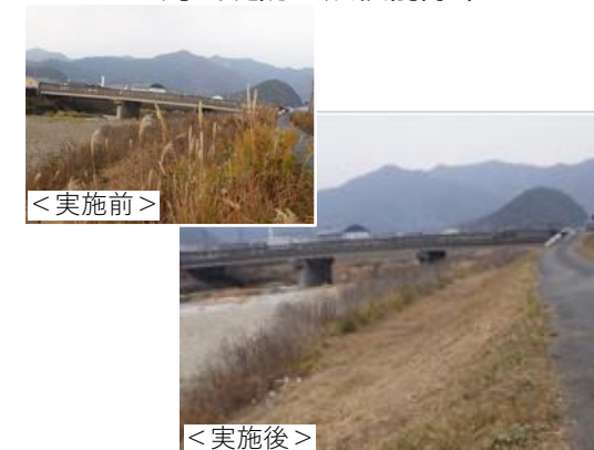
河川堤防の点検前除草
