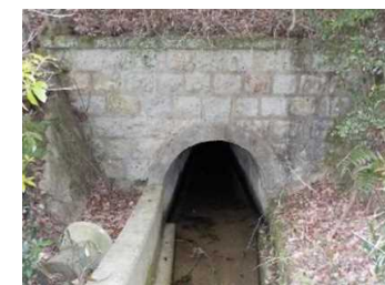
水路トンネル
