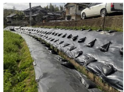
写真3 遮光シート設置状況
