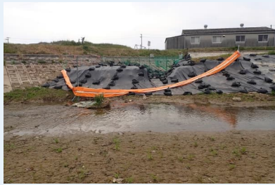
落水時に防除ネットとオイルフェンスを設置 (新仏池)
