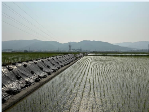
定着しないよう水際に遮光シートを敷設
