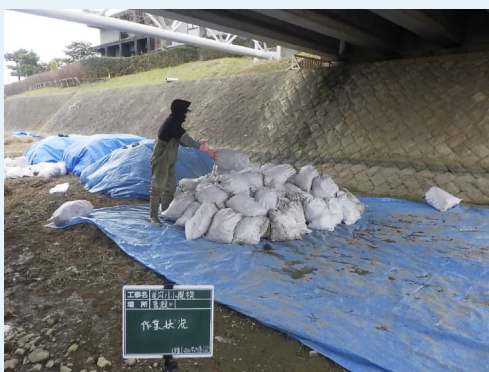
仮置きにより脱水し減量化する
