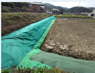
抑草効果を狙った遮光率99.9~100%の 遮光シートの設置 農林水産部実証
