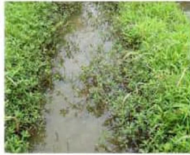
排水路（土水路）での発生
