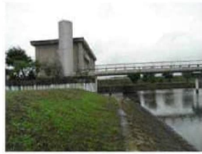
排水機場の法面
