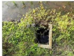
給水栓付近から定着
