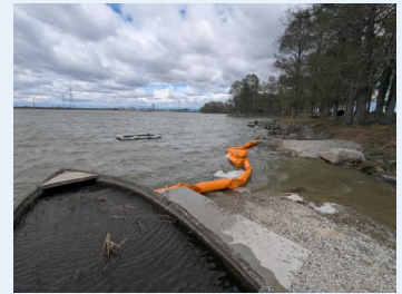
流出入防止ネット（天満大池）
