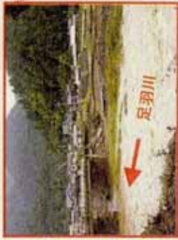
足羽川右岸堤防が護岸破損 （19日撮影）
