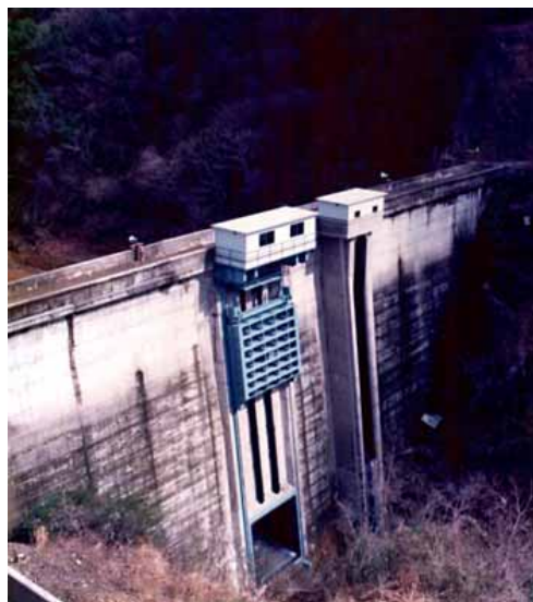
図3 藤井川ダム(元) (ダム便覧より)
