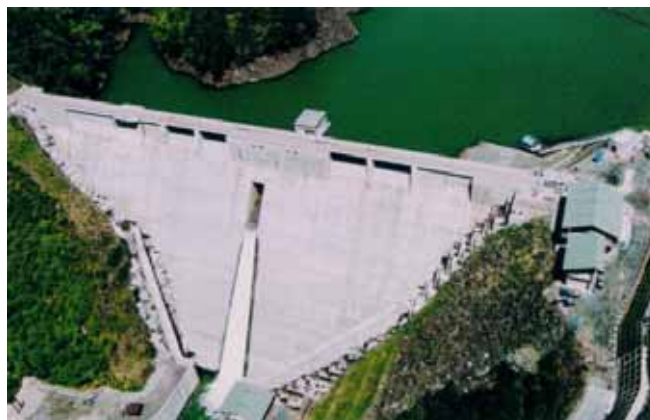
図1 姉川ダム(「月間ダム日本」2002年10月号より)
