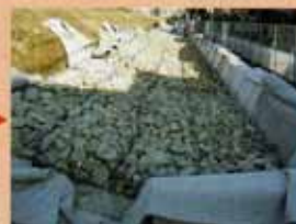
カゴマット設置後の状況
