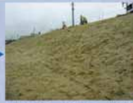
覆土ブロックを土で覆い芝を張って完成です。
