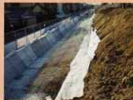
堤防内の水通しを良くするため、石などの水を良く通す材料を並べます。(ドレーン工)
