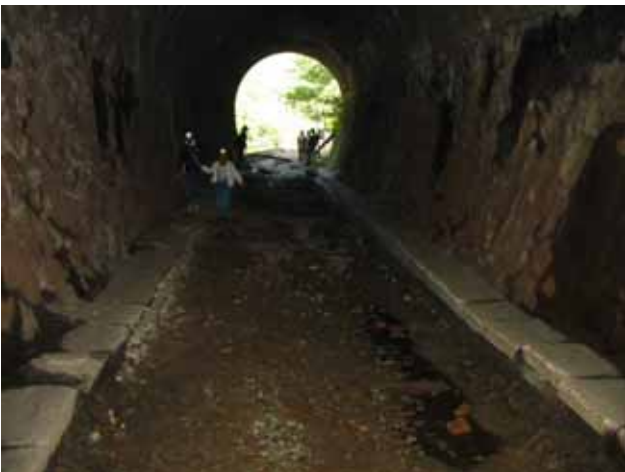
長尾山第1トンネル内部流失（上流側）
