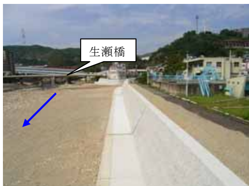
復旧完了（H17.10 時点）
