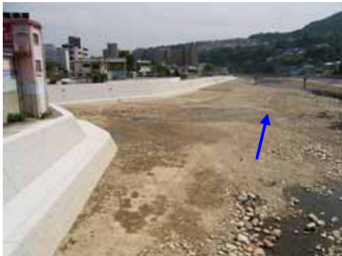
復旧完了（H17.10 時点）
