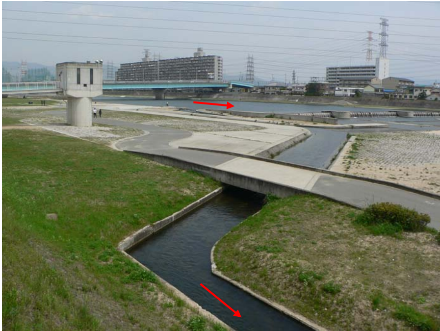
百間樋井堰と導水路（西宮市）
