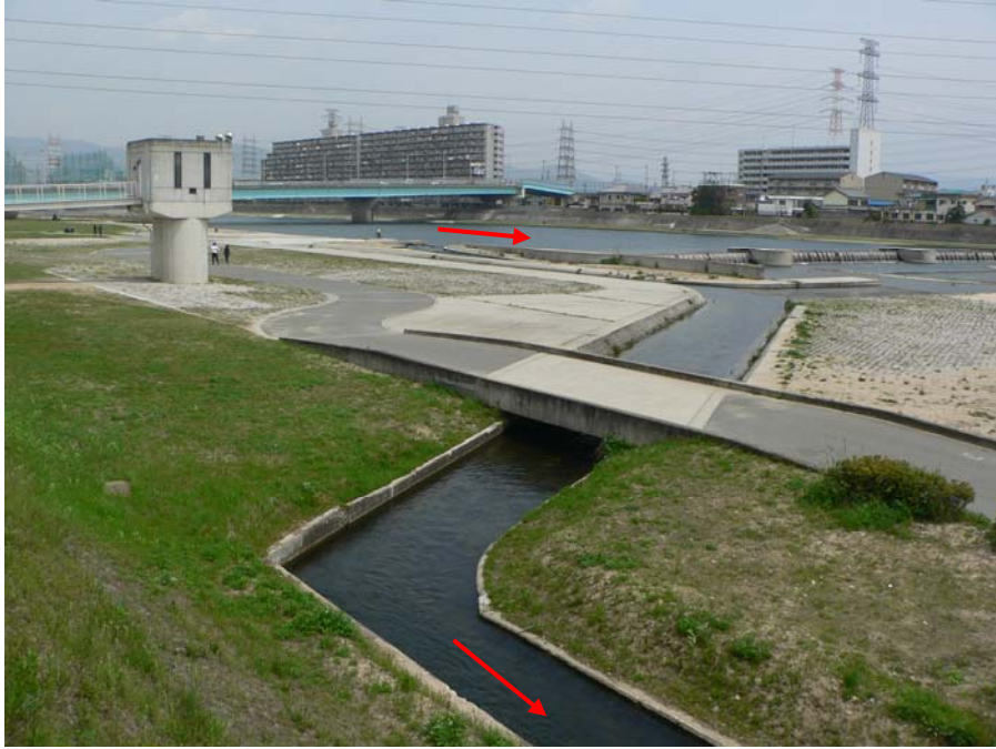
百間樋井堰と導水路（西宮市）
