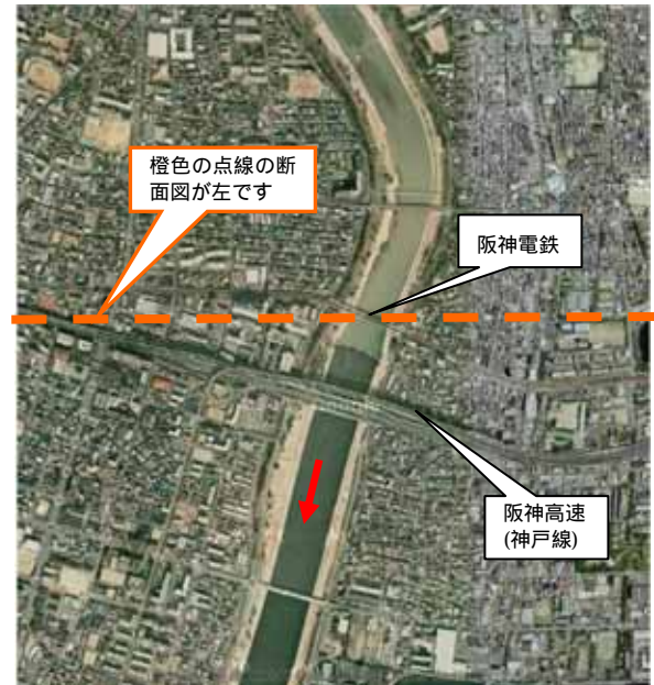
写真1 武庫川阪神電鉄橋梁付近
