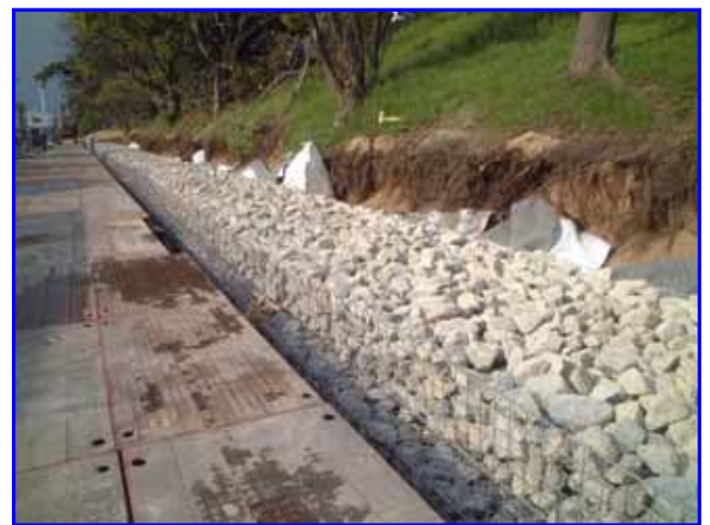
写真1 堤防裏法尻のドレーン工
