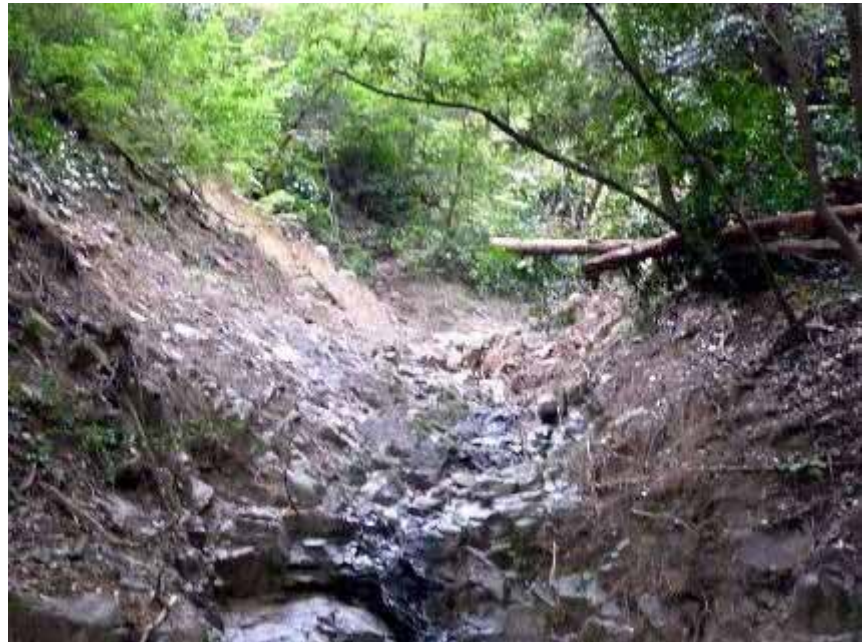
山腹崩壊(一部)
