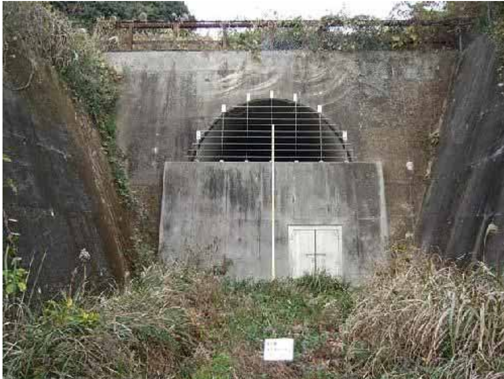
第 3 湊トンネルの坑口。トンネルの長さは約 920m、坑内の高さは最大 5.7m、幅は最大 4.8m。坑口までの距離は国道 204 号から約 600m
