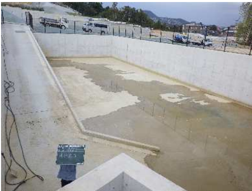
西宮市高塚町調整池
