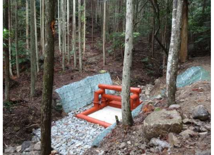
災害緩衝林の整備（簡易流木止め工の設置：三田市上本庄）
