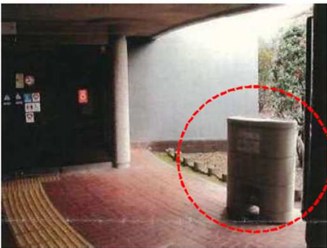
雨水貯留タンク（左：三田庁舎、右：西宮庁舎）
