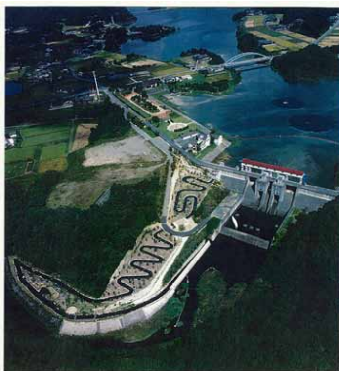
図 2.2.12 青野ダム多自然型魚道
