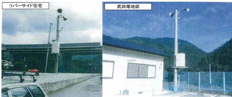
サイレン・回転灯の設置
