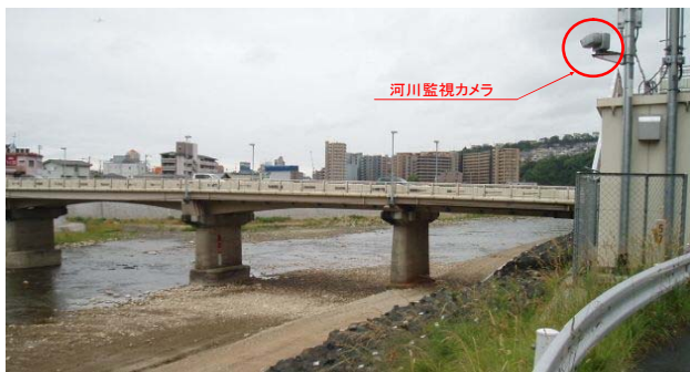
河川監視カメラの設置
