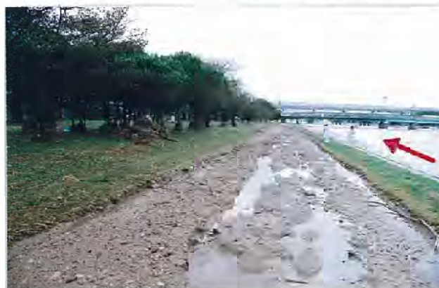
高水敷の露地面
