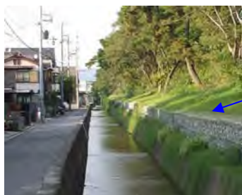
写真 4.1.1 ドレーン工法*の施工例
