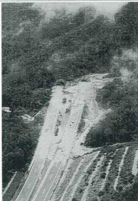
土砂崩れで埋まった舞鶴道のトンネル (正午、兵庫県丹南町で) ←本社ヘリから
