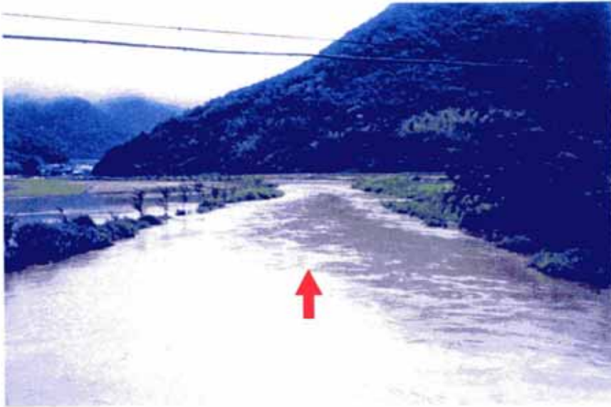
船瀬橋より下流の状況
