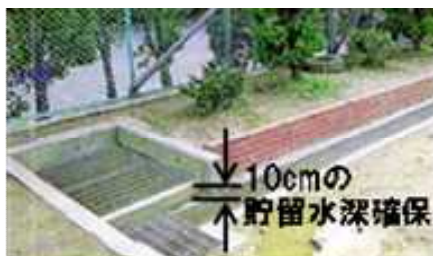
学校(校庭)における雨水貯留(川西南中学校)
