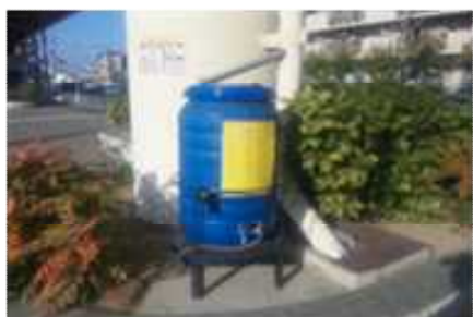
雨水貯留タンク(川西市)
