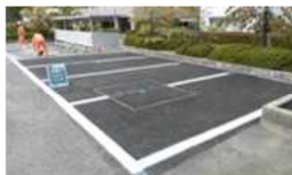
庁舎(駐車場)における浸透舗装(県伊丹庁舎)
