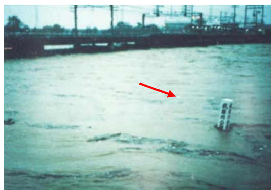
写真 2.1.7 昭和58年台風10号による洪水の状況（阪神電鉄橋梁付近）
