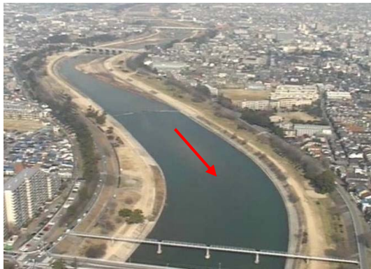
写真 2.2.1 下流部築堤区間
