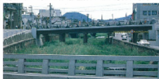
● 昭和初期に施工された流路工(平成元年)
