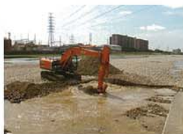
堆積土砂撤去
