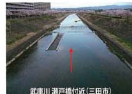
武庫川 瀬戸橋付近(三田市) 改善指標④ コンクリート護岸の割合が多い場所
