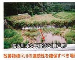
船坂川 水久保橋付近(神戸市) 改善指標③川の連続性を確保すべき場所
