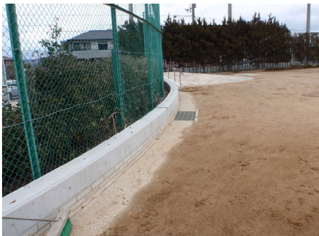
雨水貯留施設 (周囲小堤)
