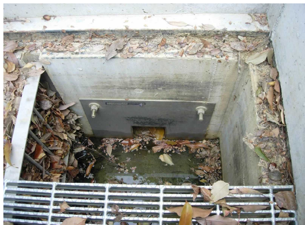
雨水貯留施設 (放流施設)
