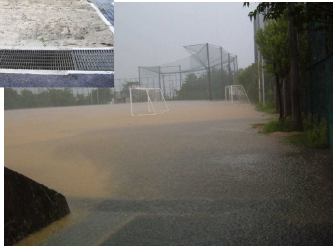
雨水貯留状況 (大雨時)
